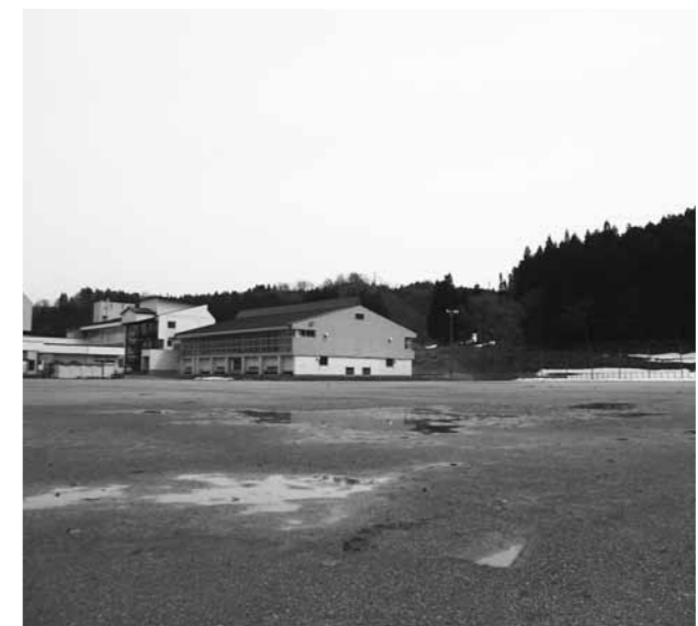
土砂災害土石流危険区域に指定されている校舎
