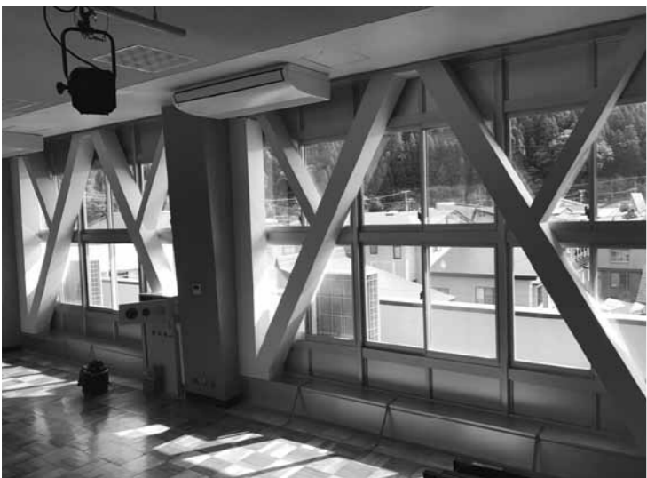
耐震工事が完了し安心して使えるようになった中央公民館
