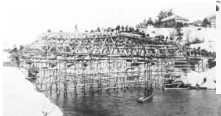
長沢橋工事（昭和初期）
