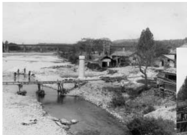
舟形橋取り付け道路工事
